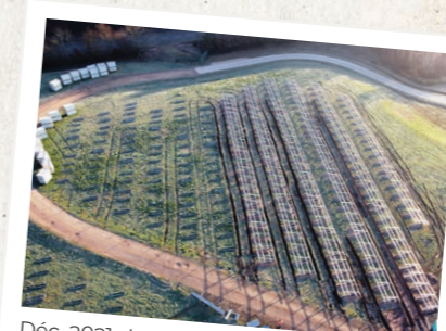
Déc. 2021 : les fondations sont en place. Les premières structures sont installées.
